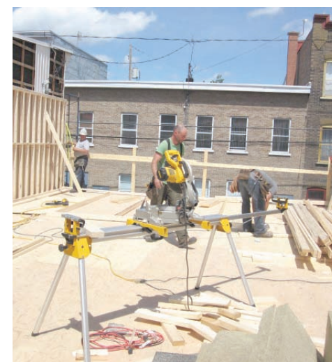
Chantier sur la rue St-François Ouest.
