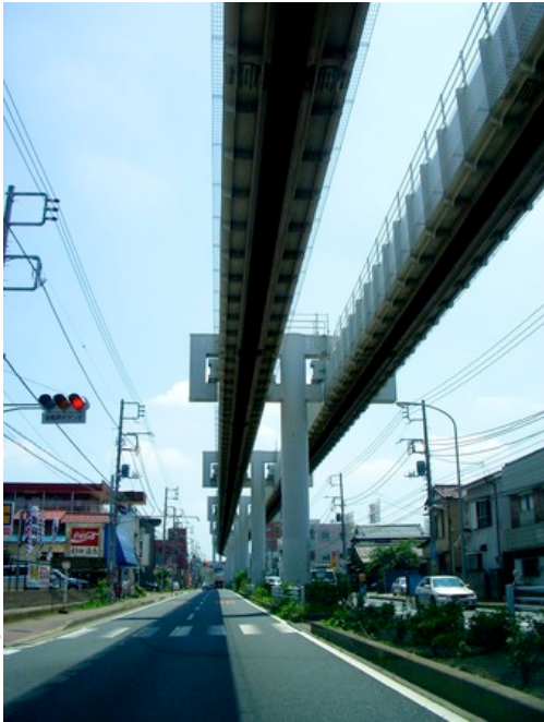
1. Ce monorail roule sur des pneus.
