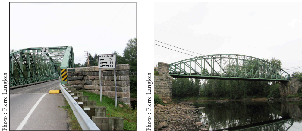
1. Ce pont en acier de 59 mètres de longueur a été inauguré en 1891. Photos prises en août 2010.
